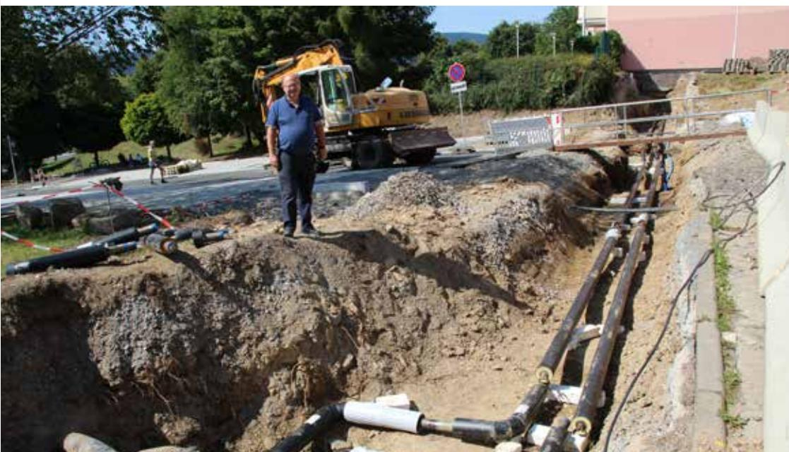
Der technische Leiter Detlef Hunold inspiziert die Isolierung der neuen Fernwärme-Trasse Am Fichtbusch
